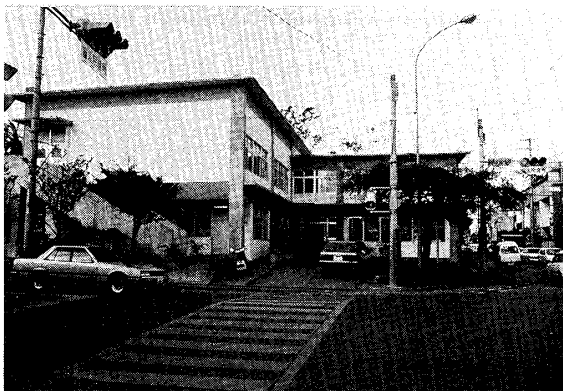
石垣市文化会館（旧琉球文化会館）
