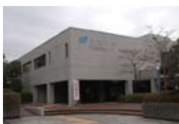
学習センター（千葉） （全国に50箇所）
