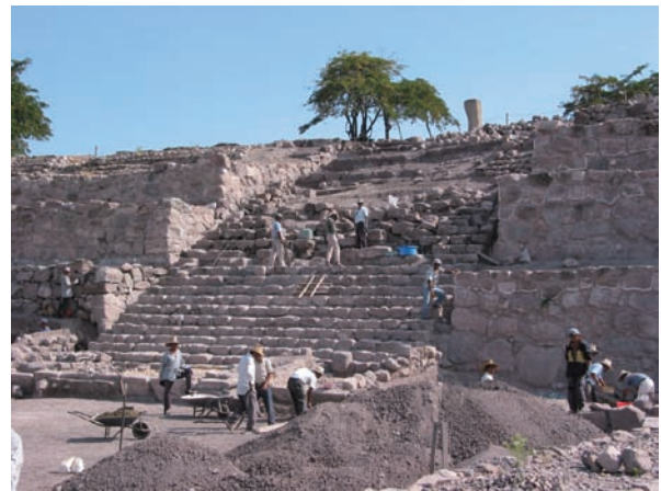
写真5 クントウル・ワシ神殿の修復
