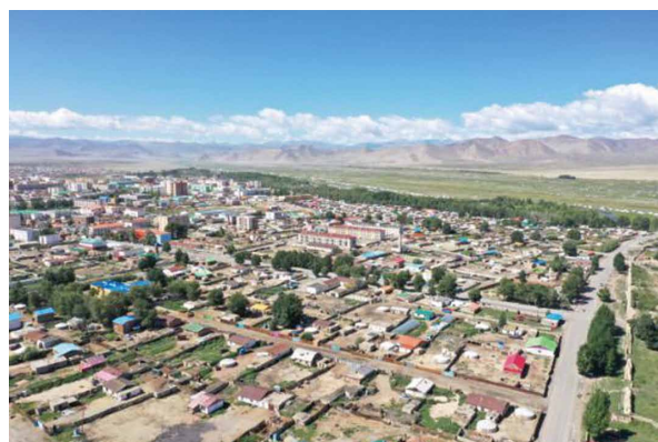
写真2 ホブド市内のドローンによる斜め撮影
